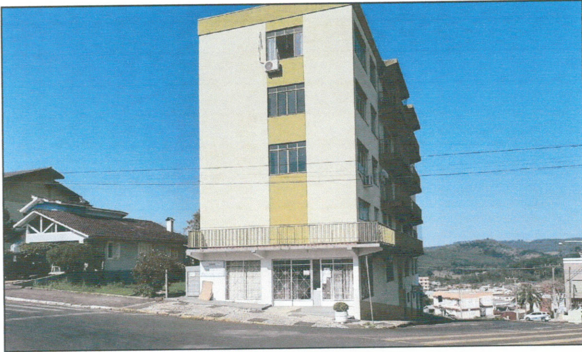
Foto 1: Fachada do imóvel
