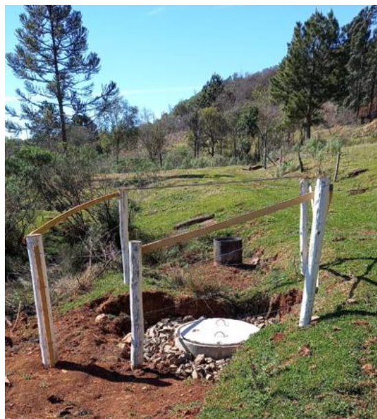
Figura 17: Sistemas de proteção de fontes instaladas em área rural do município
