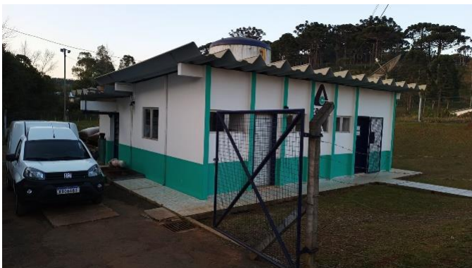
Figura 7: Estação de Tratamento de Água
