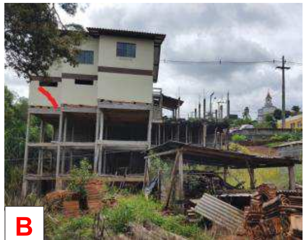
Figura 126: A: Indícios de que está havendo movimentação nesta encosta, a seta amarela indica o sentido do movimento. B: casa sobre pilotis construída sobre esta encosta, em vermelho indica-se onde existe uma trinca
