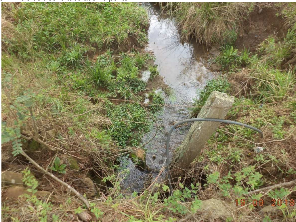
Figura 31: Início de trecho tubulado no ponto 21.
