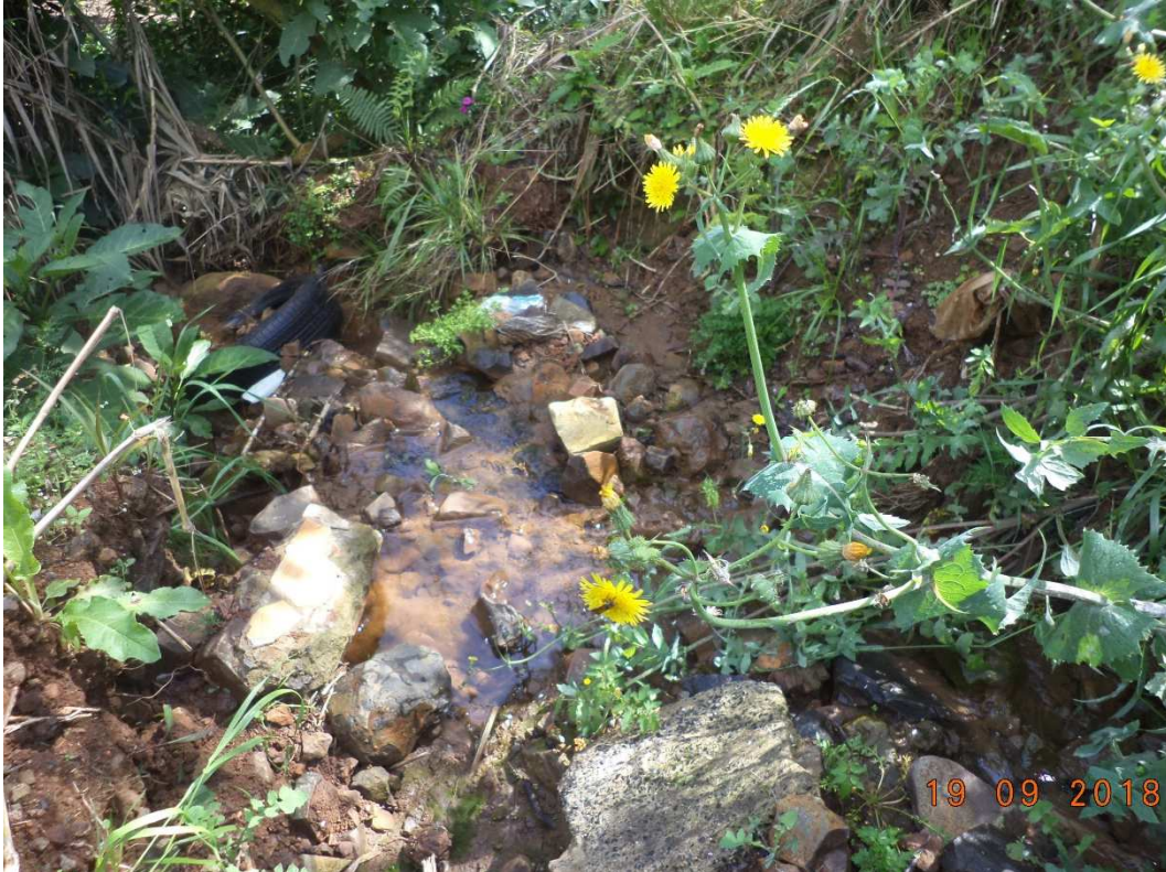
Figura 19: Termino de tubulação curso d'água "C3" ponto 16.
