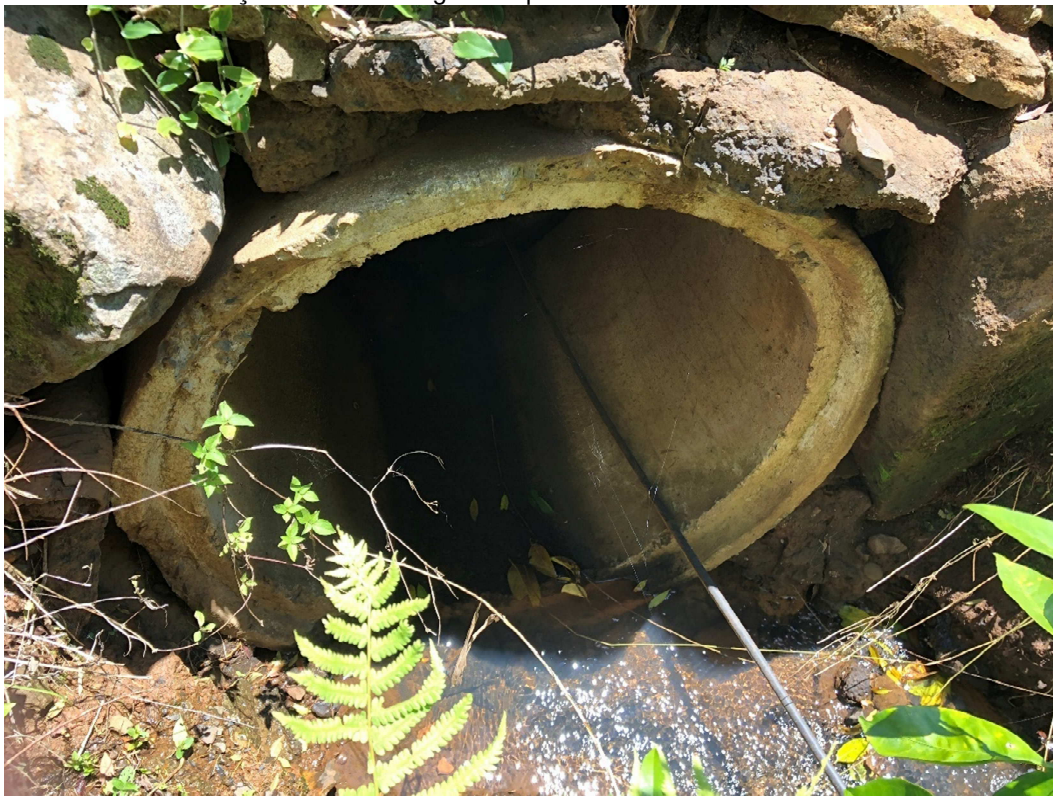
Figura 45: Início de tubulação do curso d'água "F" ponto 45.
