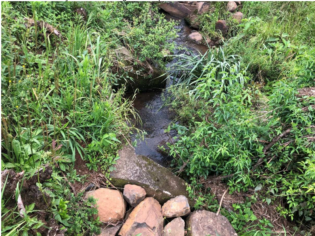
Figura 56: Início de tubulação do curso d'água "I" no ponto 39.
