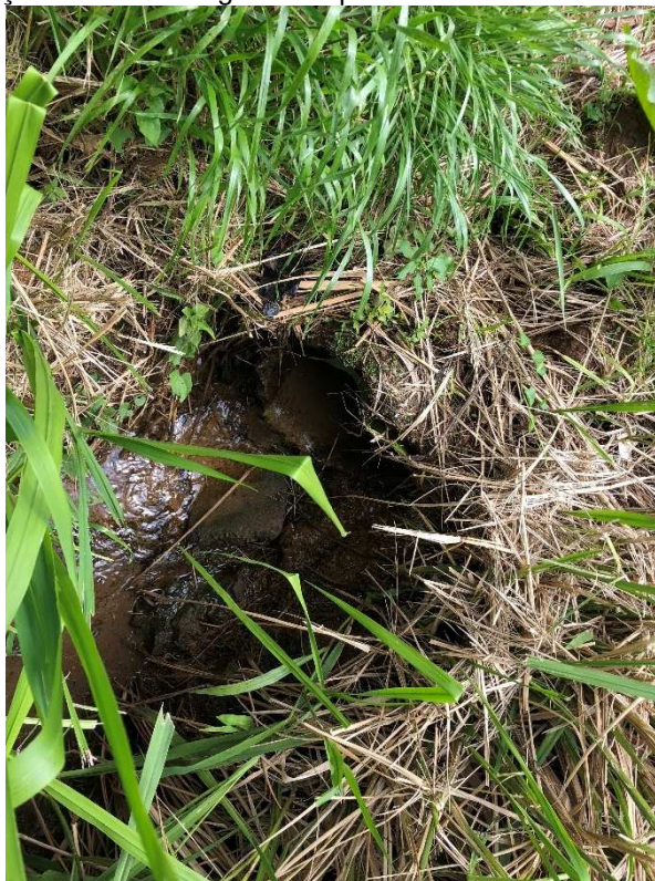
Figura 42: Final de tubulação no curso d'água "B1" ponto 43.
