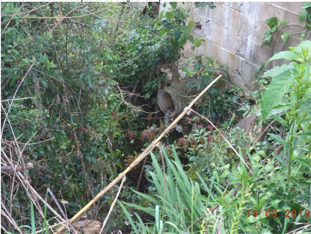
Figura 20: Termino de tubulação curso d'água "C3" ponto 18.
