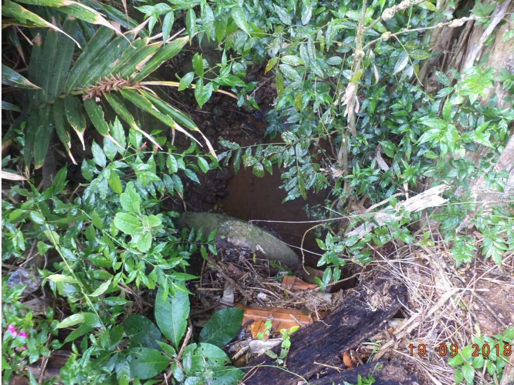
Figura 21: Início de tubulação curso d'água "C3" ponto 19.
