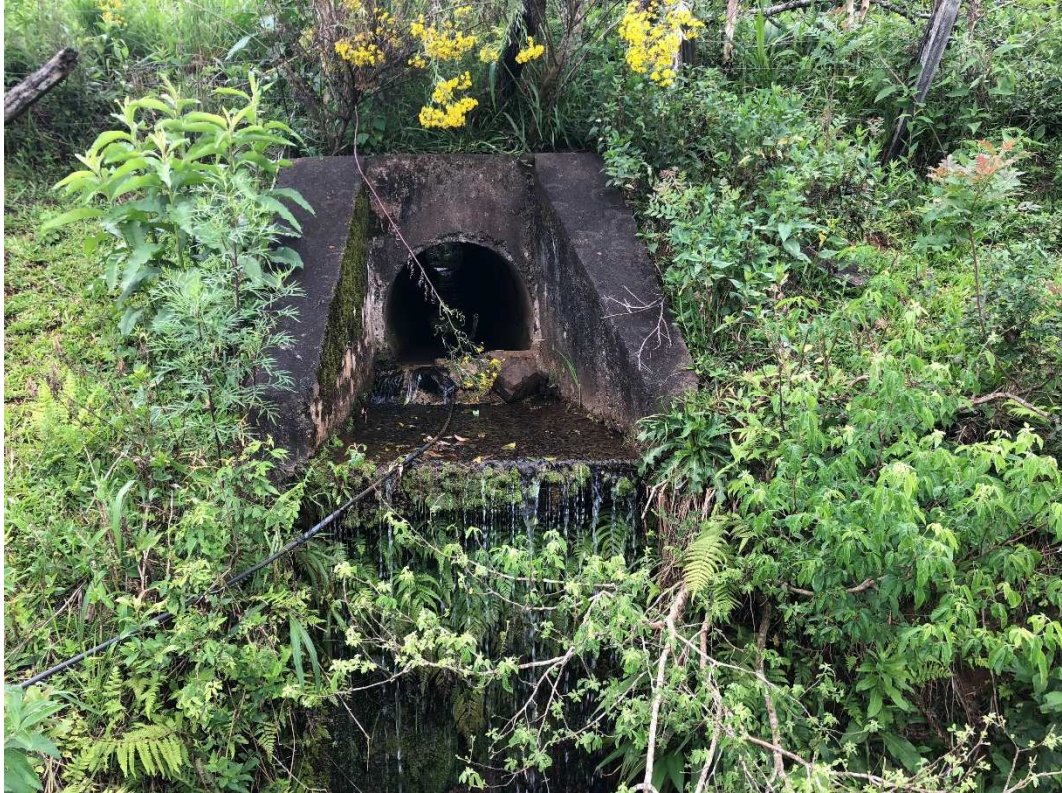
Figura 53: Termino da tubulação do curso d'água "I1" no ponto 36.
