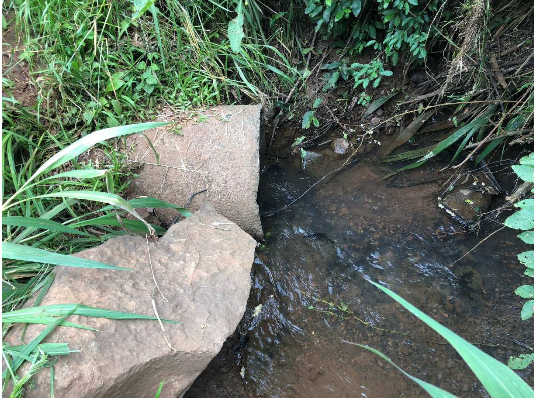
Figura 55: Início de tubulação do curso d'água "I" no ponto 38.
