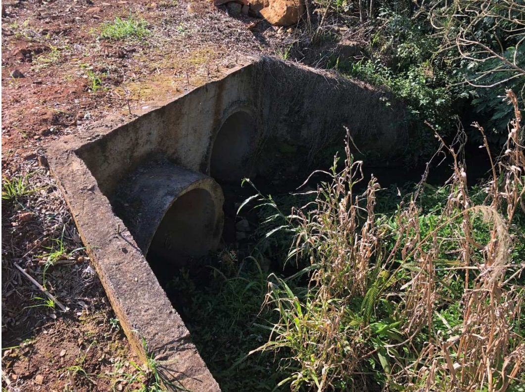
Figura 17: Curso d'água "C", ponto de encontro e início de tubulação ponto 14.
