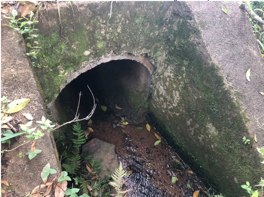
Figura 52: Início da tubulação de travessia da SC-150 do curso d'água "11" no ponto 35.
