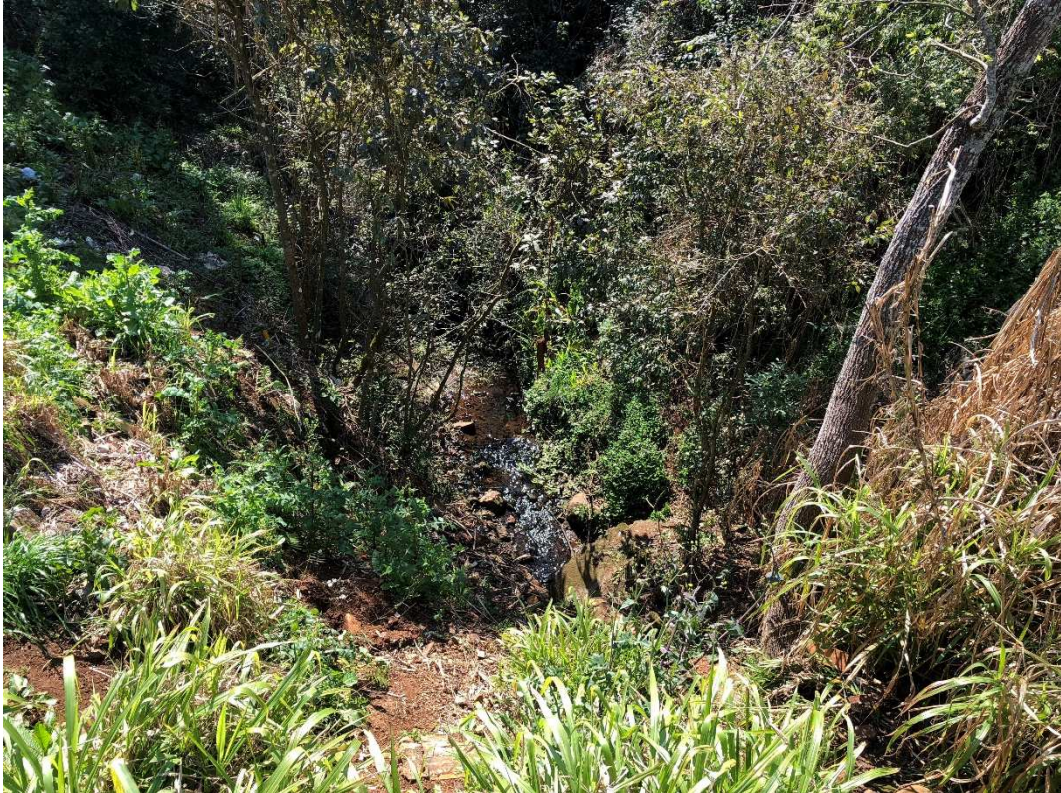
Figura 15: Início de tubulação no curso d'água "C" ponto 11.
