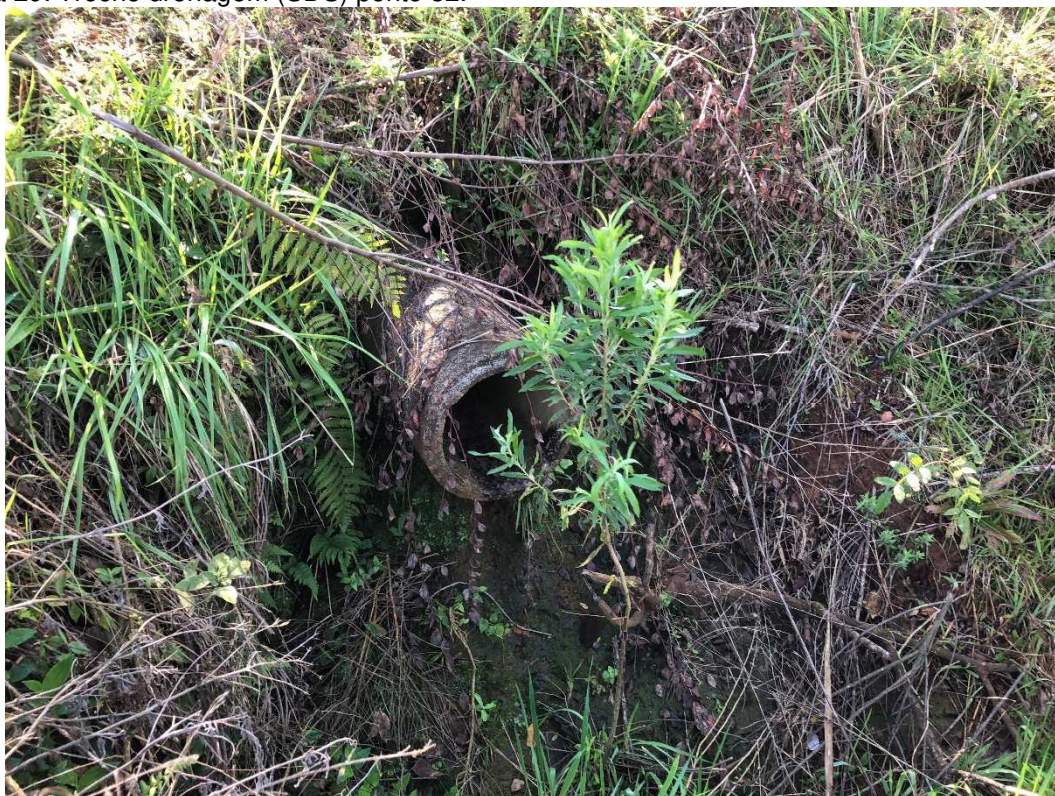
Figura 29: Trecho drenagem (SDS) ponto 32.
