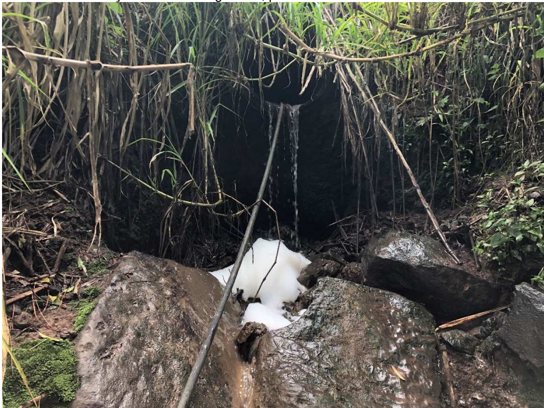
Figura 39: Saída de tubulação do curso d'água "G", ponto 40.
