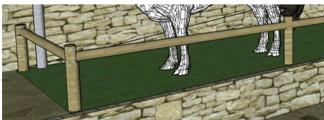
**CERCA DE EUCALIPTO TRATADO:** submetido ao processo de tratamento em autoclave com aplicação de solução C.C.A. (cobre cromo e arsênio) que ficam totalmente preservadas contra os ataques de insetos, cupins, brocas ou fungos de apodrecimento. Isso com garantia total de mais de 15 anos. O objetivo é conferir ao eucalipto tratado uma durabilidade maior, protegendo-os do ataque
