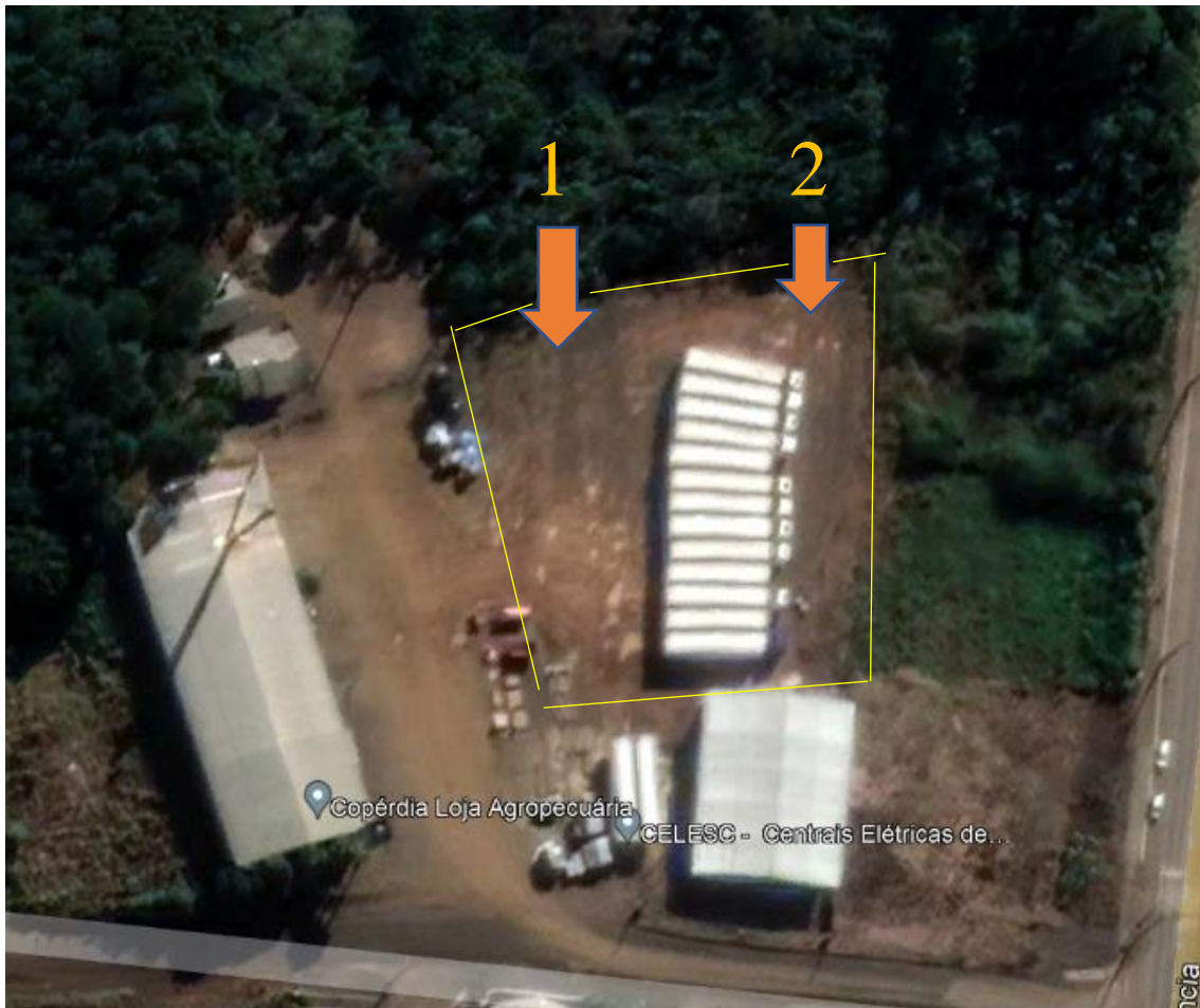
Figura 1–Imagem Google Earth da área de estudo com pontos indicados para sondagem no extremo Norte.
