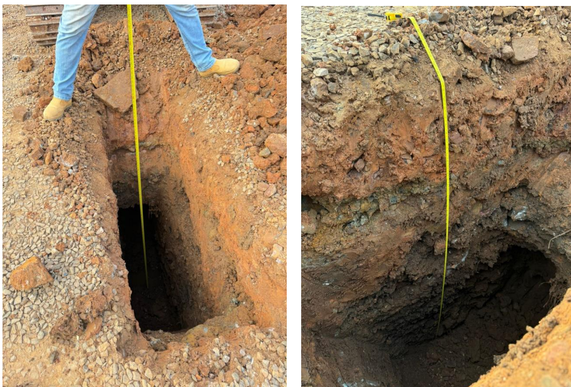
A sondagem com lençol freático aos 3,60m, sendo que o aterramento no local de 1,50m.
