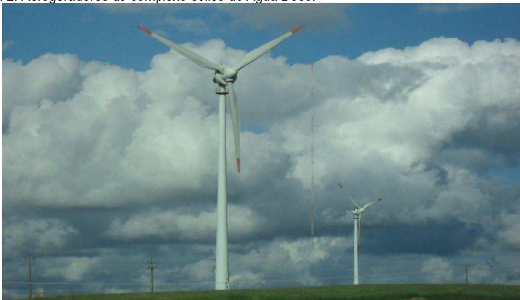
Figura 2: Aerogeradores do complexo eólico de Água Doce.
