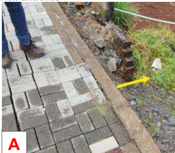
Figura 126: A: Indícios de que está havendo movimentação nesta encosta, a seta amarela indica o sentido do movimento. B: casa sobre pilotis construída sobre esta encosta, em vermelho indica-se onde existe uma trinca
