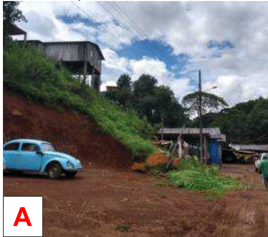
Figura 125: A: Casa de madeira construída sobre pilotis na crista da encosta. B: Blocos de rocha soltos com risco de queda.
