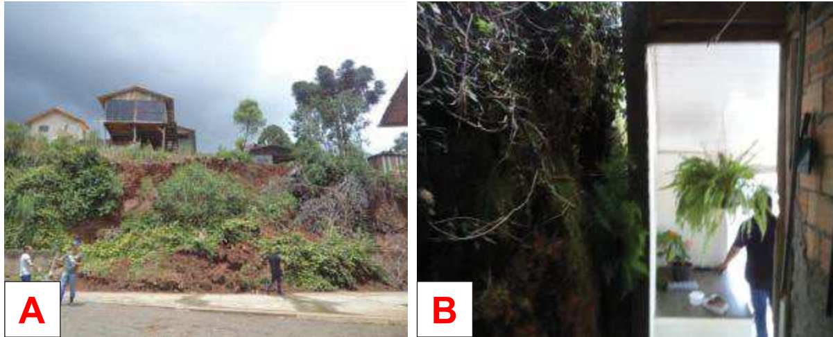
Figura 129: A: Deslizamento de terra ocorrido nesta área de risco. B: Casa construída muito próxima ao corte no talude.
