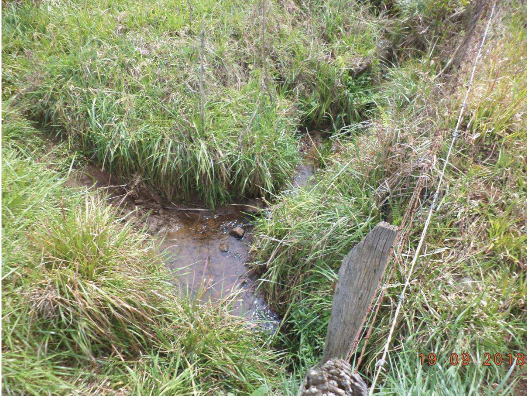
Figura 13: Início de trecho tubulado no ponto 24.
