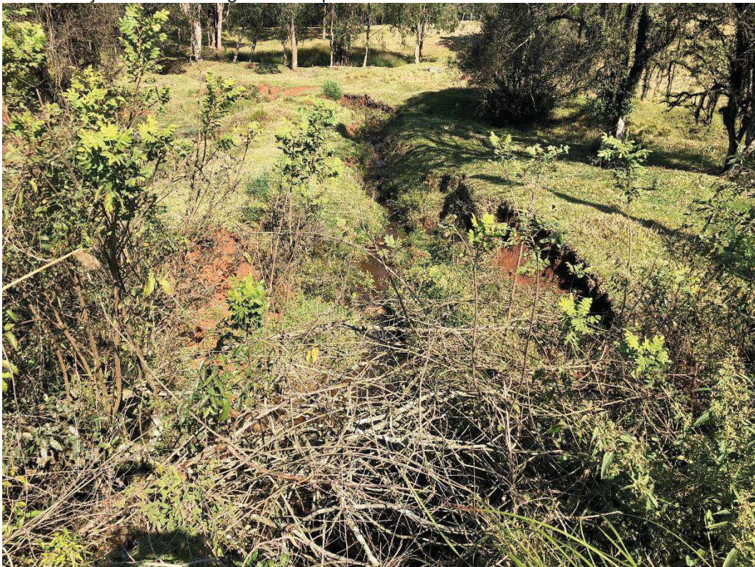
Figura 4: Tubulação do curso d'água "A" no ponto 5.
