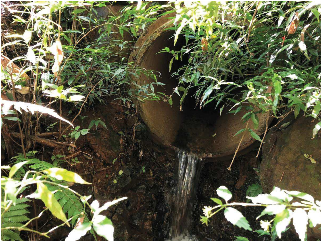
Figura 28: Término de tubulação no curso d'água "C3" ponto 31.
