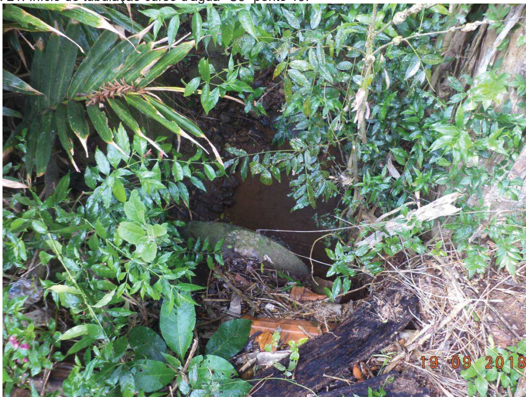
Figura 21: Início de tubulação curso d'água "C3" ponto 19.
