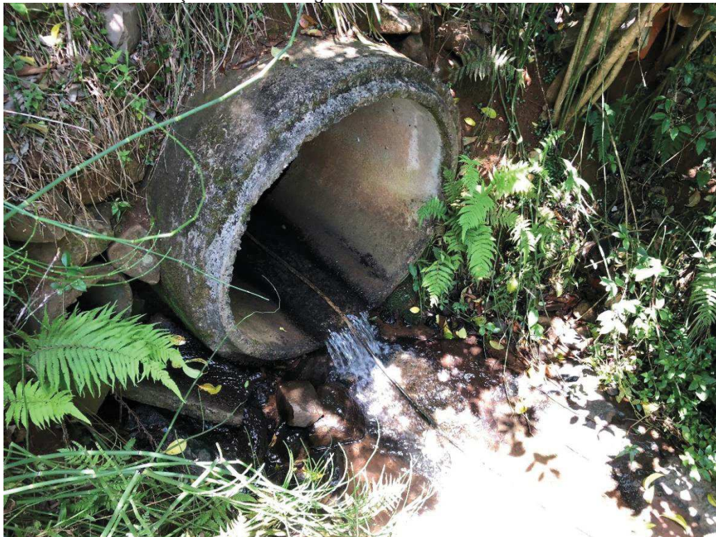
Figura 44: Término de tubulação do curso d'água "F" ponto 44.
