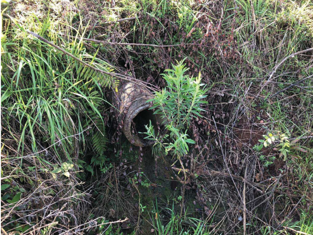
Figura 29: Trecho drenagem (SDS) ponto 32.
