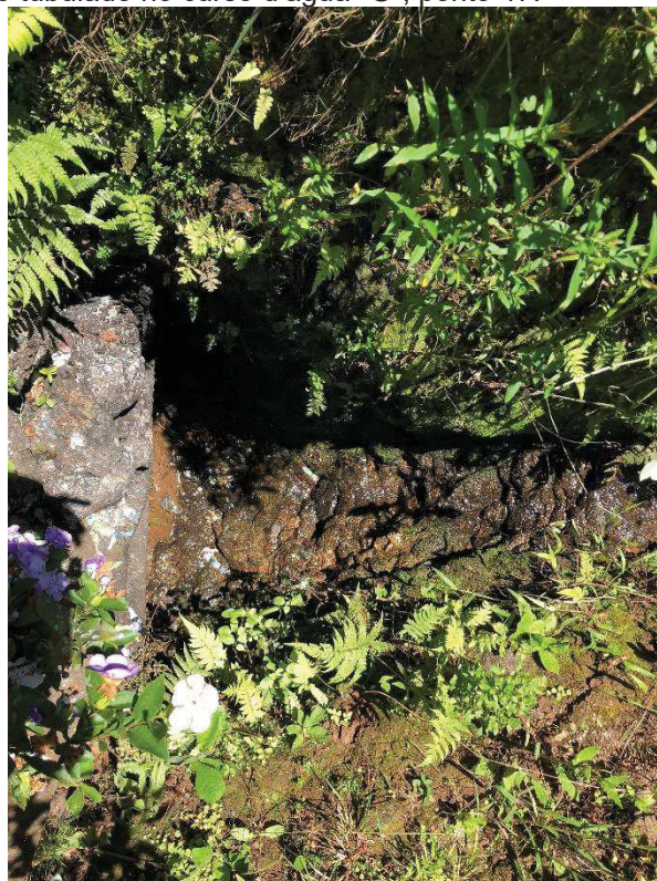
Figura 46: Início de trecho tubulado no curso d'água "G", ponto 47.
