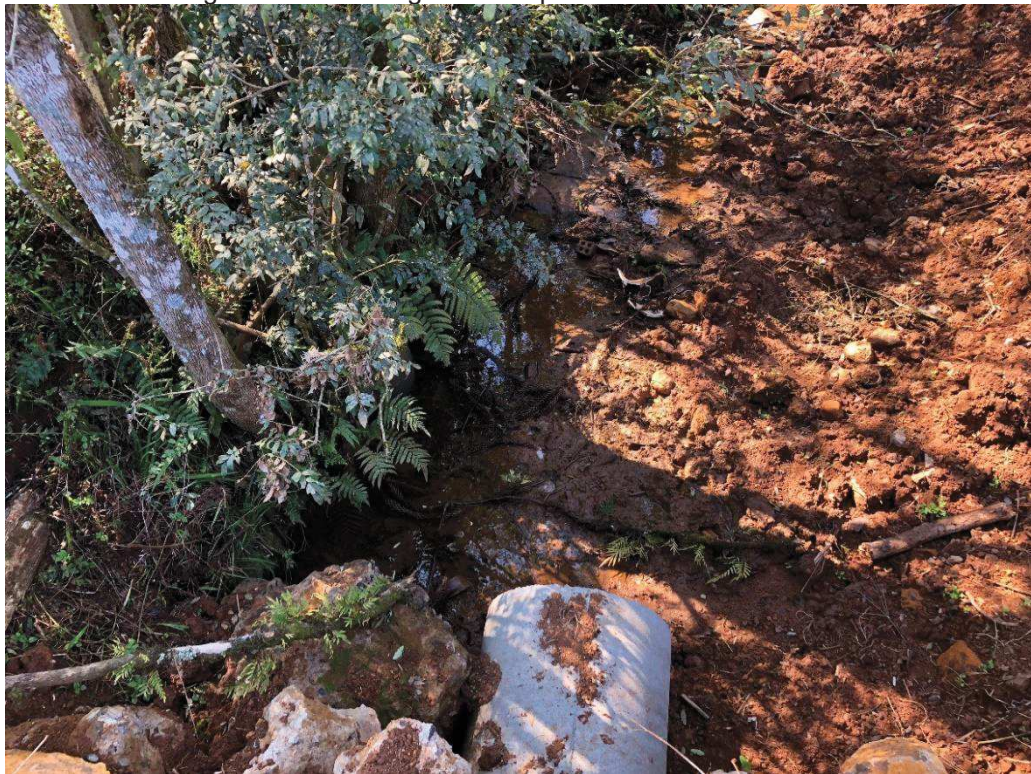
Figura 7: Início da drenagem do curso d'água "B" no ponto 6.
