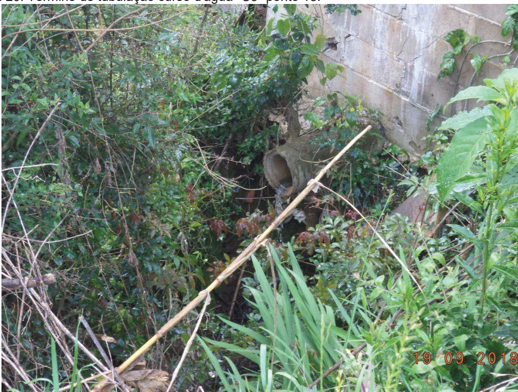
Figura 20: Termino de tubulação curso d'água "C3" ponto 18.
