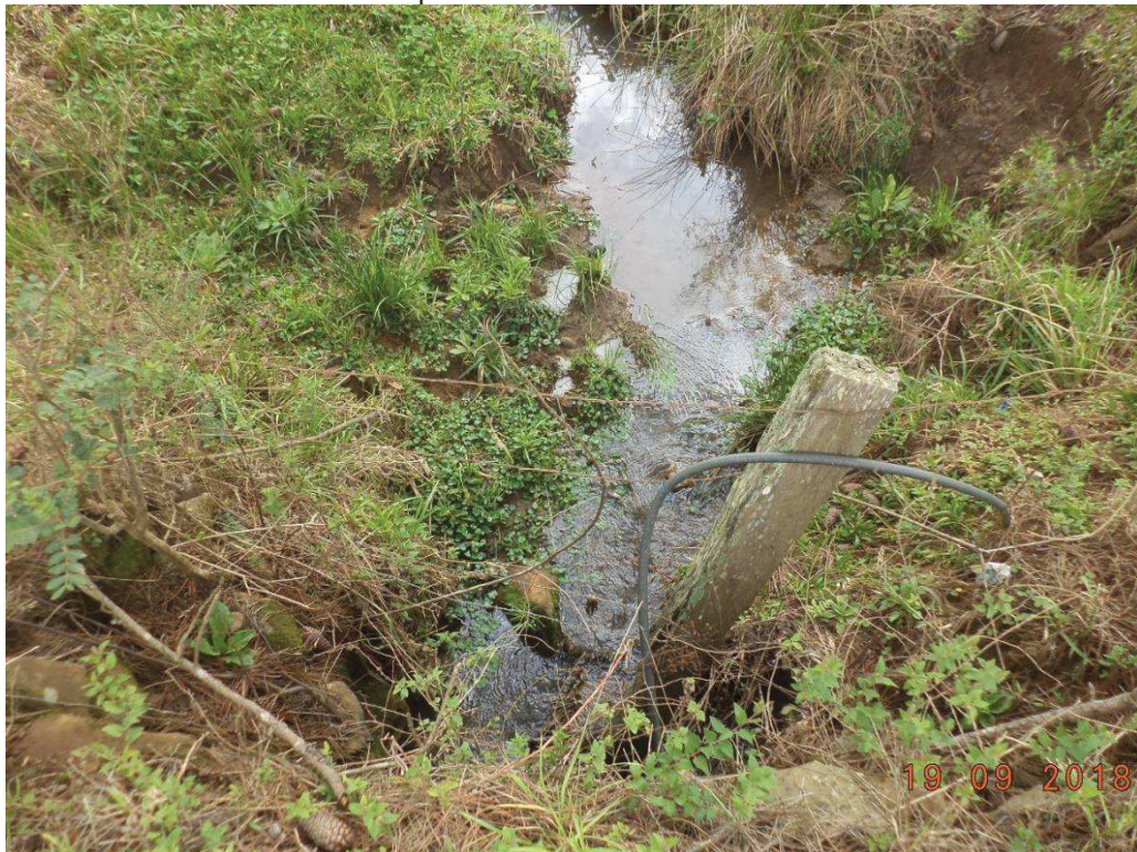
Figura 31: Início de trecho tubulado no ponto 21.
